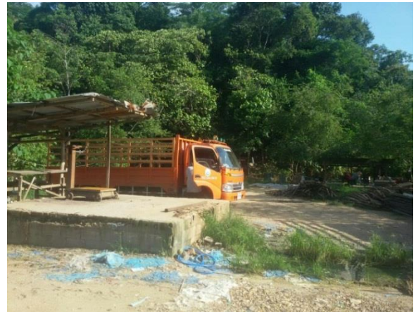
ดำเนินการปรับและเตรียมพื้นที่เพื่อก่อสร้างฝาย
